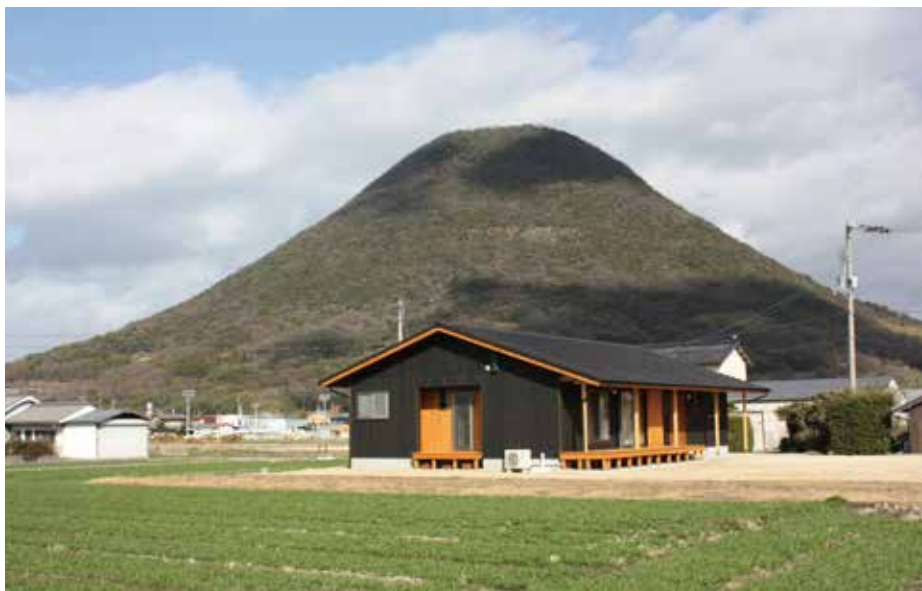
設計・施工：和住宅
