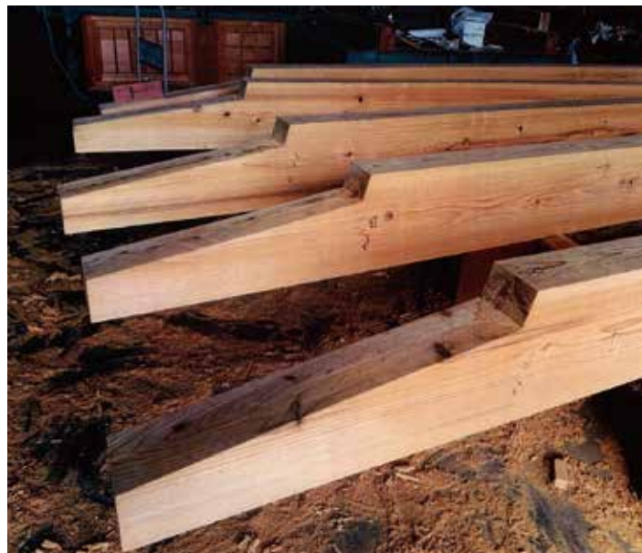
乾燥後プレカッタされた状態。割れがなく見事に仕上がっています。
