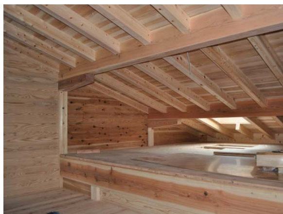
岐阜の工務店が建築中のモデルハウス (天井、壁、床)
