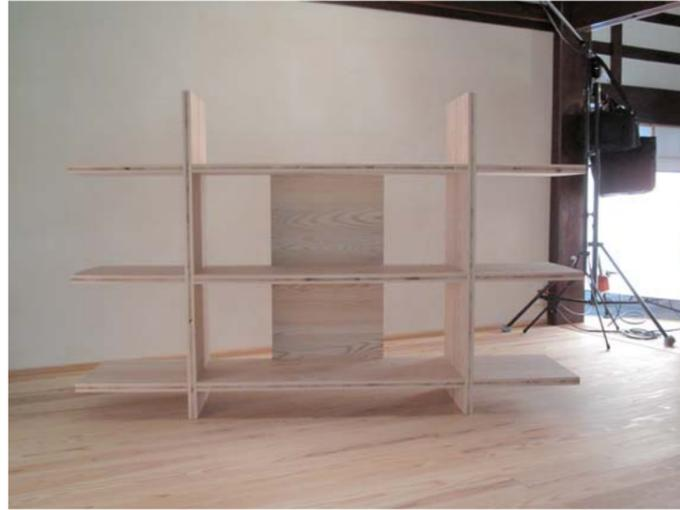
横板(棚板)に縦板を前後から挟み込む組み式構造。横板の撓みを軽減するためです。
