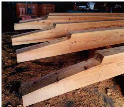
乾燥後プレカットされた状態。割れがなく見事に仕上がっています。
